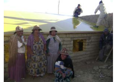
Die Frauen arbeiten gemeinsame an einem Solar-Gewächshaus.
